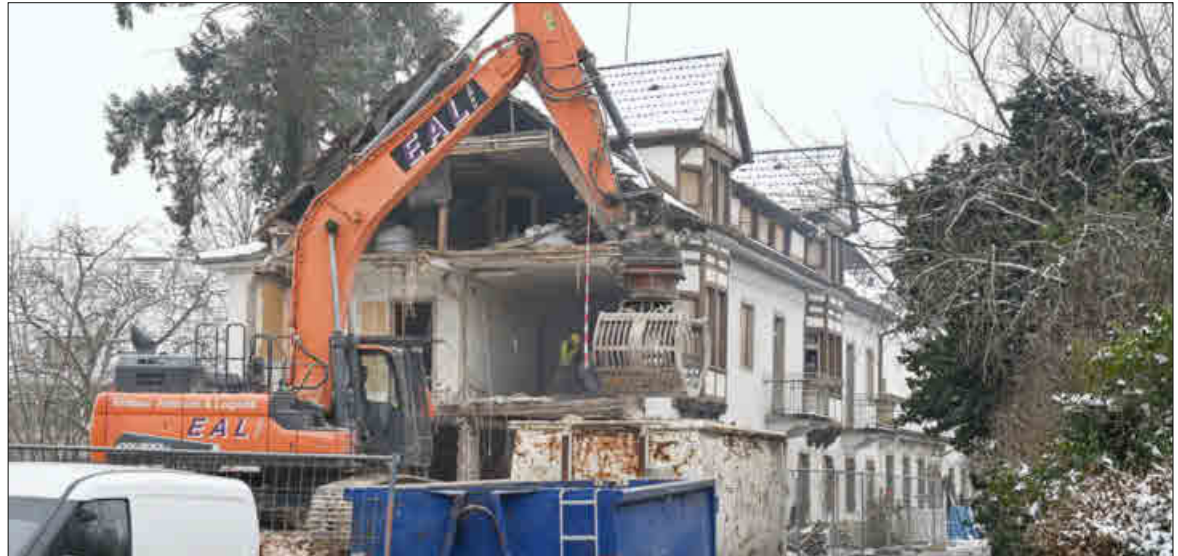
In der vergangenen Woche wurde mit dem Abriss des Gebäudes begonnen.
